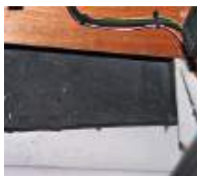
Isolierung 1: Matten zwischen beschichtetem Rumpf und Innenausbau oberhalb der Wasserlinie
