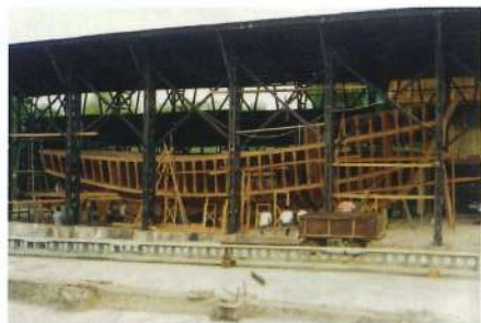
EEN OPNAME UIT DE INDONESISCHE PERIODE, EEN WERF IN TANJUNG PRIK, WAAR EEN 45 VOETS LONGLINER IN AANBOUW IS.
